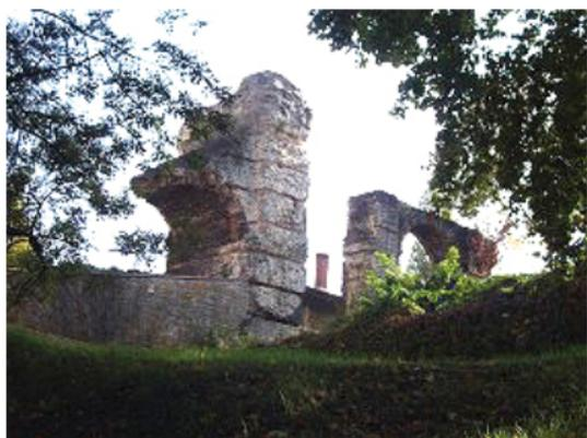
Après la traversée du plateau de Sainte-Foy-lès-Lyon, le canal sort de terre dans l'enceinte du fort Saint-Irénée, où cinq piles sont conservées, dont deux reliées par une arche. La plus au nord supportait, à 11 m au-dessus du sol, le réservoir de chasse du dernier siphon de l'aqueduc, celui de Trion (On peut voir depuis la rue
