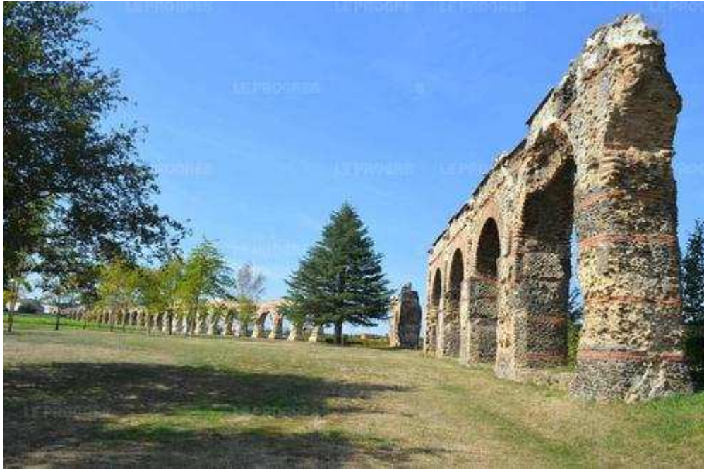
L'aqueduc gallo-romain du Gier. Photo Progrès /Laurene PERRUSSEL-MORIN
