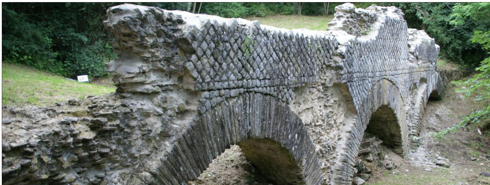
■ Le pont du Jurieux est désormais sécurisé. Photo Valérie HEBERT
